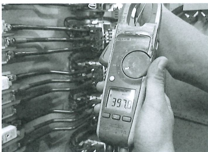
การตรวจสอบแรงดันไฟฟ้าก่อนการทำงานที่ตู้ไฟฟ้าด้วย digital meter
